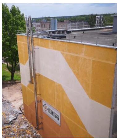
Рисунок 2 – Приставной утепленный дымоход
