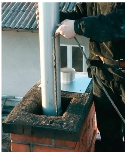
Рисунок 1 – Загильзовка кирпичного дымохода
