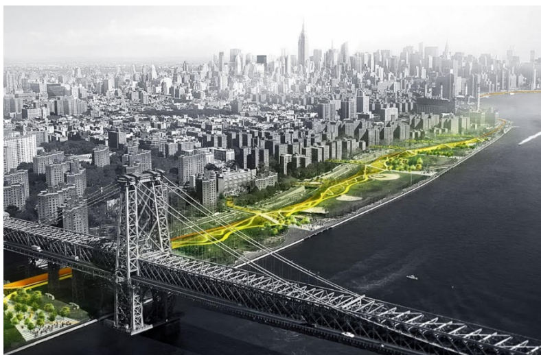
Рис. 3. Комплекс сооружений, защищающих прибрежные районы Нью-Йорка от наводнений
