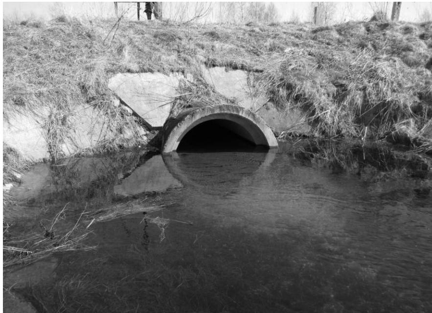
Рисунок 4.64 – Труба-регулятор на канале Поведский (НБ)
