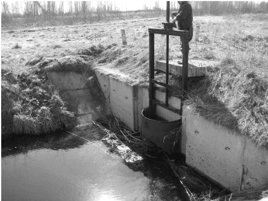
Рисунок 4.63 – Труба-регулятор на канале Поведский (ВБ)
