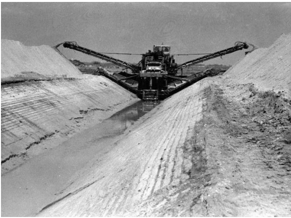
Рисунок 3.72 – Строительство осушительного канала
