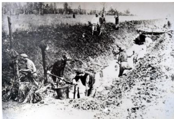
Рисунок 3.70 – Работы по устройству канала
