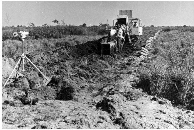
Рисунок 3.73 – Строительство закрытого материального дренажа
