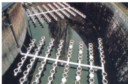
*Рисунок 3 – Тарельчатые аэраторы*
