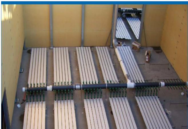
*Рисунок 1 – Плоские аэраторы*
