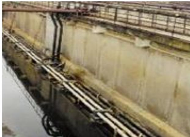
*Рисунок 2 – Трубчатые аэраторы*
