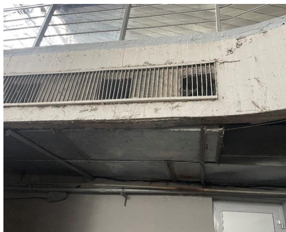
Рисунок 4 – Воздуховоды и воздухораспределительные решетки
