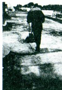
Рисунок 2 – Машины для резки кровли МРК
