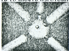
1 – полусфера, 2 – внутренняя шайба с выпуклой поверхностью; 3 – наружная шайба с вогнутой поверхностью; 4 – болт; 5 – силовая гайка; 6 – контргайка; 7 – центрирующий штифт Рис.1 – Узловой элемент системы «БРГТУ»
