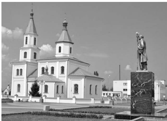
Рисунок 1.30 – г. Иваново. Покровская церковь
