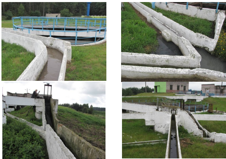
Рис. 4.16. Общий вид и конструктивное решение лотков
