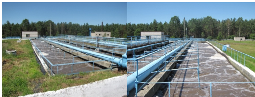
Рис. 4.9. Общий вид и конструктивное решение аэротенков
