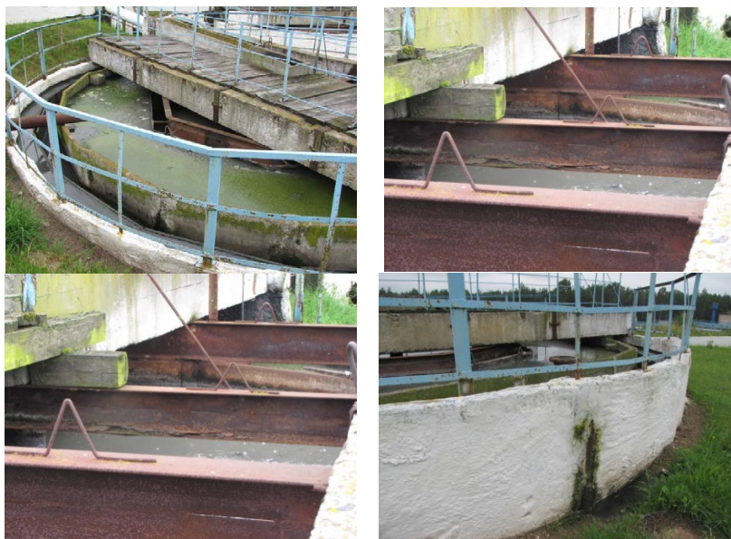
Рис. 4.6. Техническое состояние первичных отстойников
