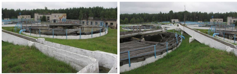
Рис. 4.7. Общий вид и конструктивное решение осветлителей-перегнивателей
