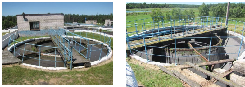
Рис. 4.3. Общий вид и конструктивное решение песколовок
