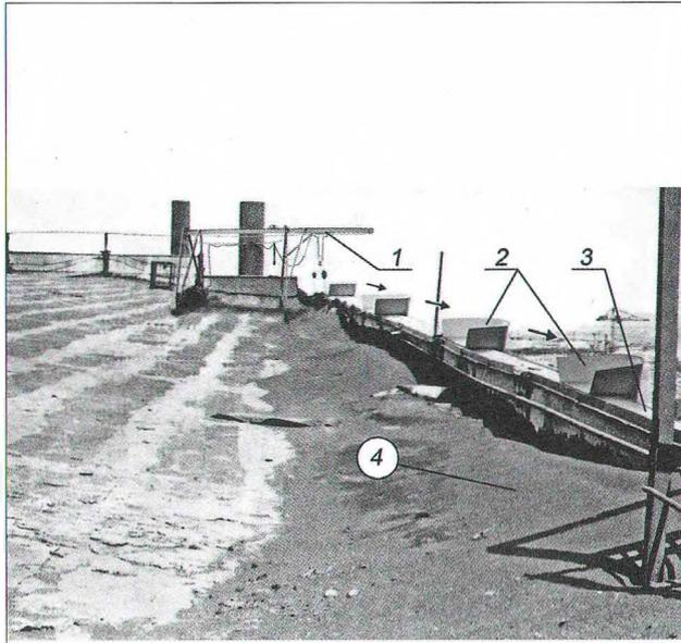
**Рис. 3. Отложение промышленной пыли у парапета производственного здания и места установки рукавов для ее уборки:**
