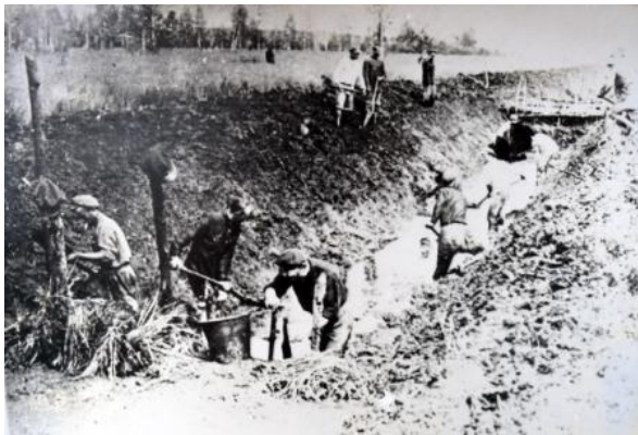
Рисунок 3.70 – Работы по устройству канала
