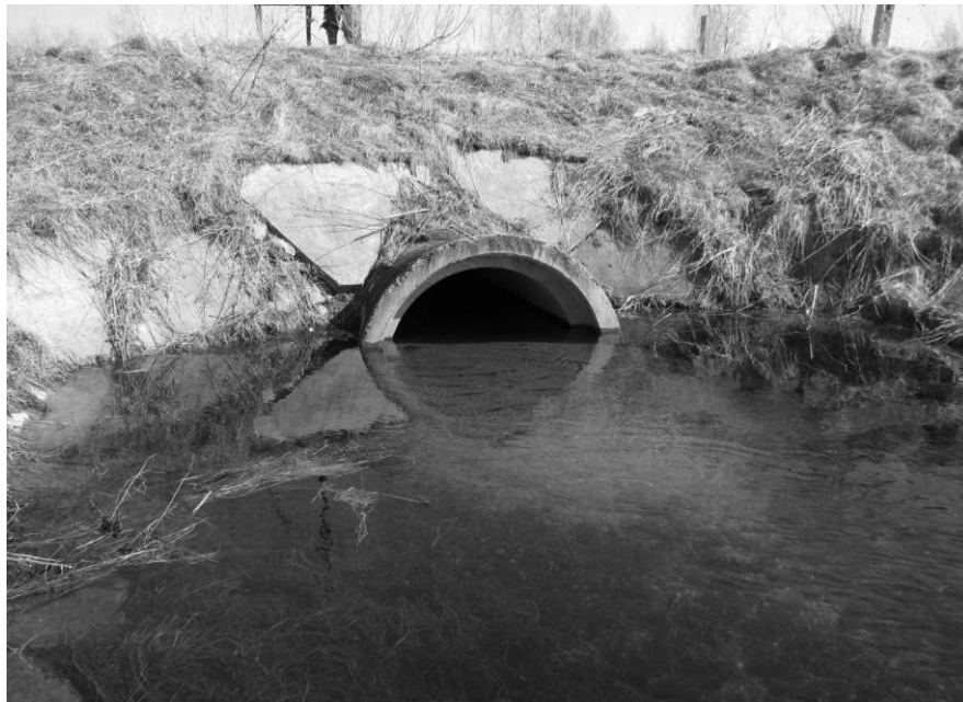
Рисунок 4.64 – Труба-регулятор на канале Поведский (НБ)
