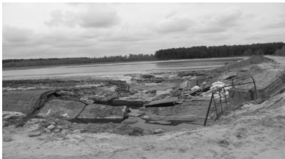
Рисунок 4.4 – Авария на водохранилище «Млынокское» (Княжеборское) (03.2010)
