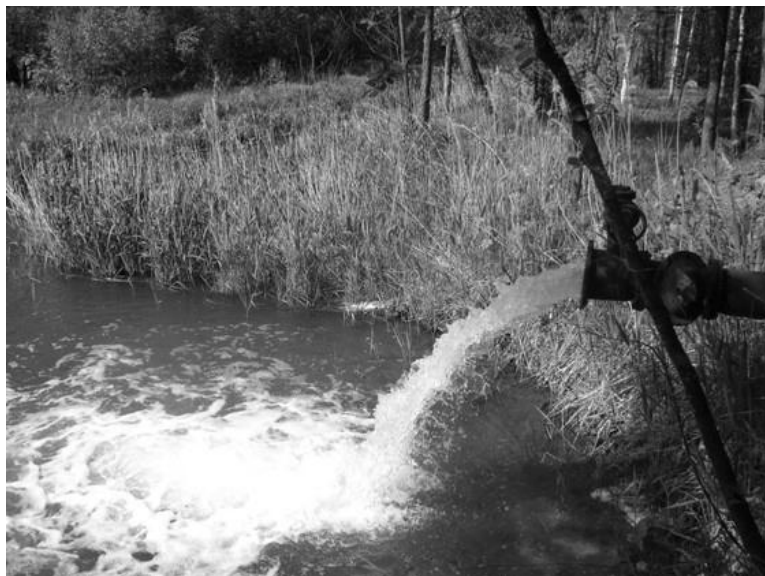
Рисунок 5.31 – Устье сбросного сооружения
