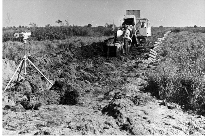
Рисунок 3.73 – Строительство закрытого материального дренажа
