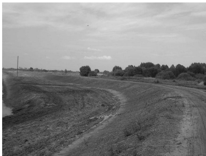
Рисунок 3.80 – Обвалование пойменных земель
