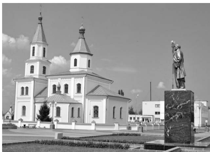
Рисунок 1.30 – г. Иваново. Покровская церковь
