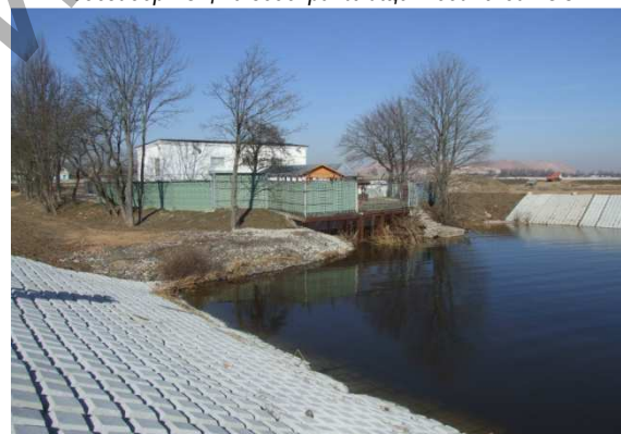
Водозабор на Солигорском водохранилище
