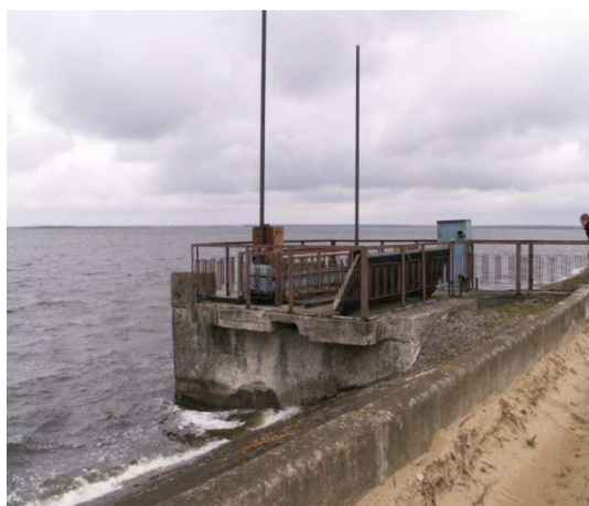
Водозабор на водохранилище Локтыши
