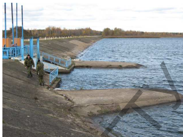
Водозабор на Любанском водохранилище
