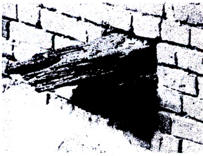
Рисунок 9 – Замоноличенные отверстия и демонтированные останки деревянных балок
