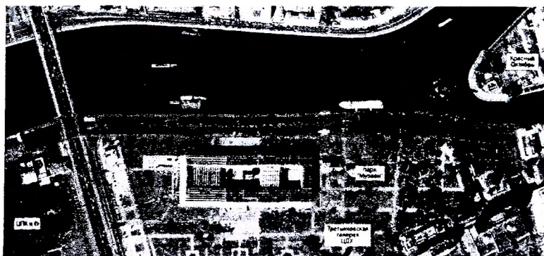
Рисунок 1 – Территория реконструкции набережной в районе Крымского моста в Москве
