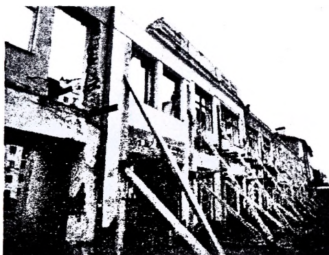
Рисунок 3 – Аутентичная стена фасада здания
