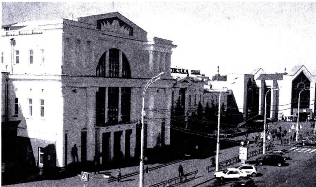
Рисунок 4 – Общий вид железнодорожных вокзалов дальнего и пригородного следования в Гомеле
