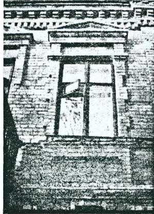
Рисунок 5 – Оформление фасада ордерными элементами
