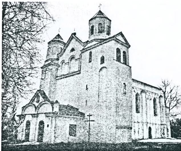
Fot. 6 – Cerkiew Św. Św. Borysa i Gleba w Nowogródku, widok od strony południowo-zachodniej, fot. J.Uścińowicz, 2001
