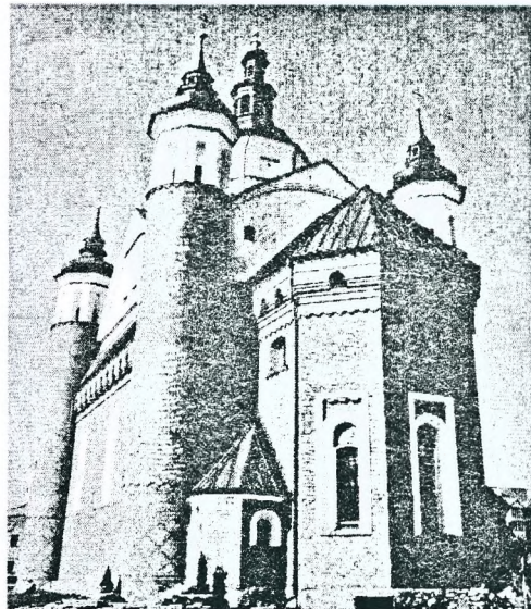
Fot. 10 – Cerkiew Zwiastowania Przenajświętszej Bogurodzicy w Supraślu, widok od strony południowo-wschodniej, fot. J. Uścińowicz, 2010
