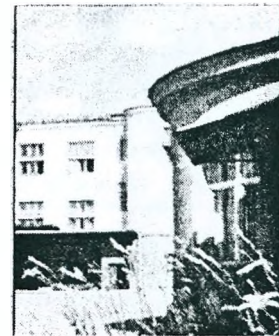
Рисунок 4 – Фрагмент дворового фасада швейной фабрики
