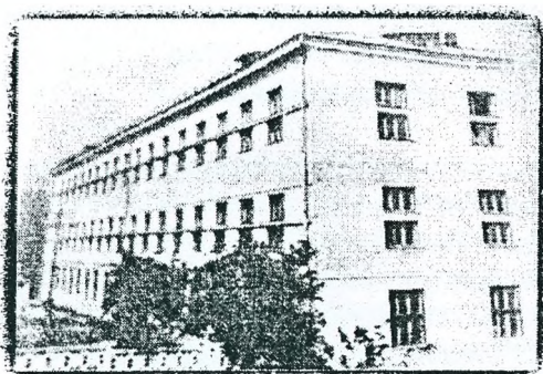
Рисунок 9 – Главный фасад пристроенного трехэтажного корпуса со стороны ул. К. Маркса
