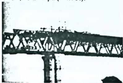
Рисунок 3 – Монтаж пролета 8-9 «в навес»
