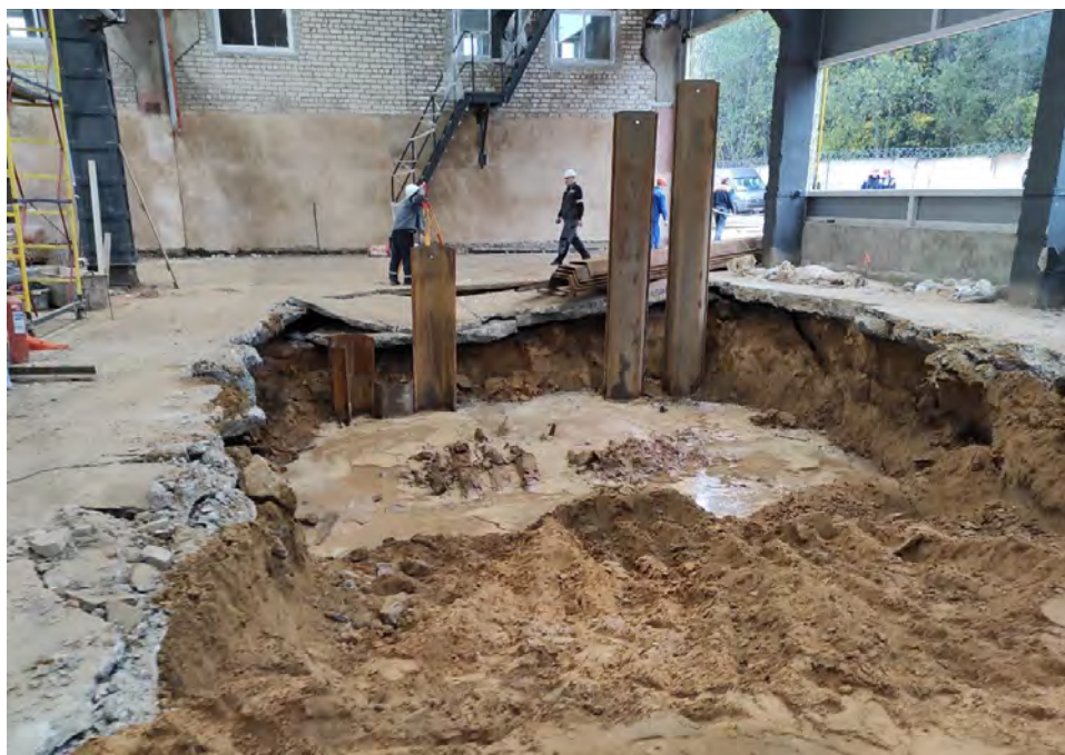
Рис.2. Состояние котлована после забивки шпунта
