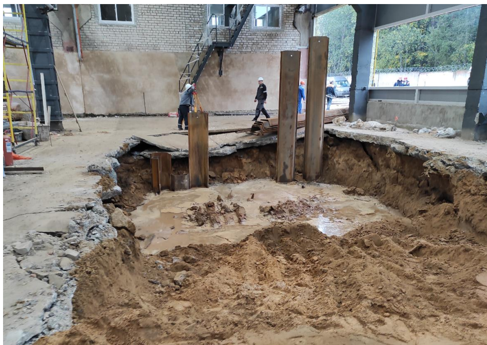
Рис.2. Состояние котлована после забивки шпунта
