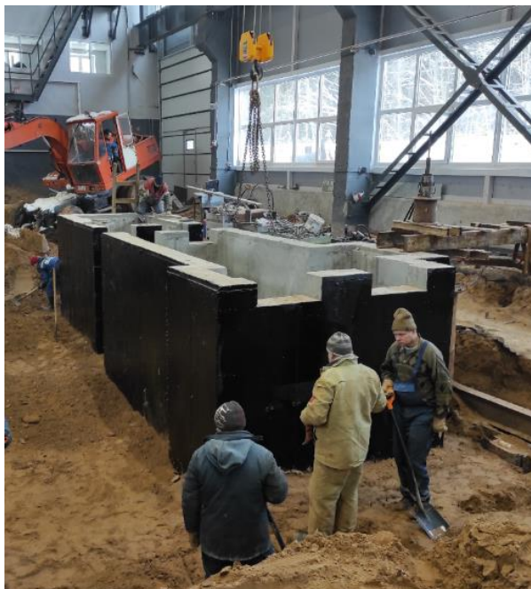
Рис.4. Общий вид фундамента под оборудование после завершения монолитных работ и частичной засыпки котлована
