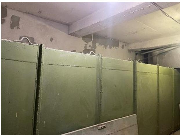
Рисунок 3 – Блок шумоглушения
