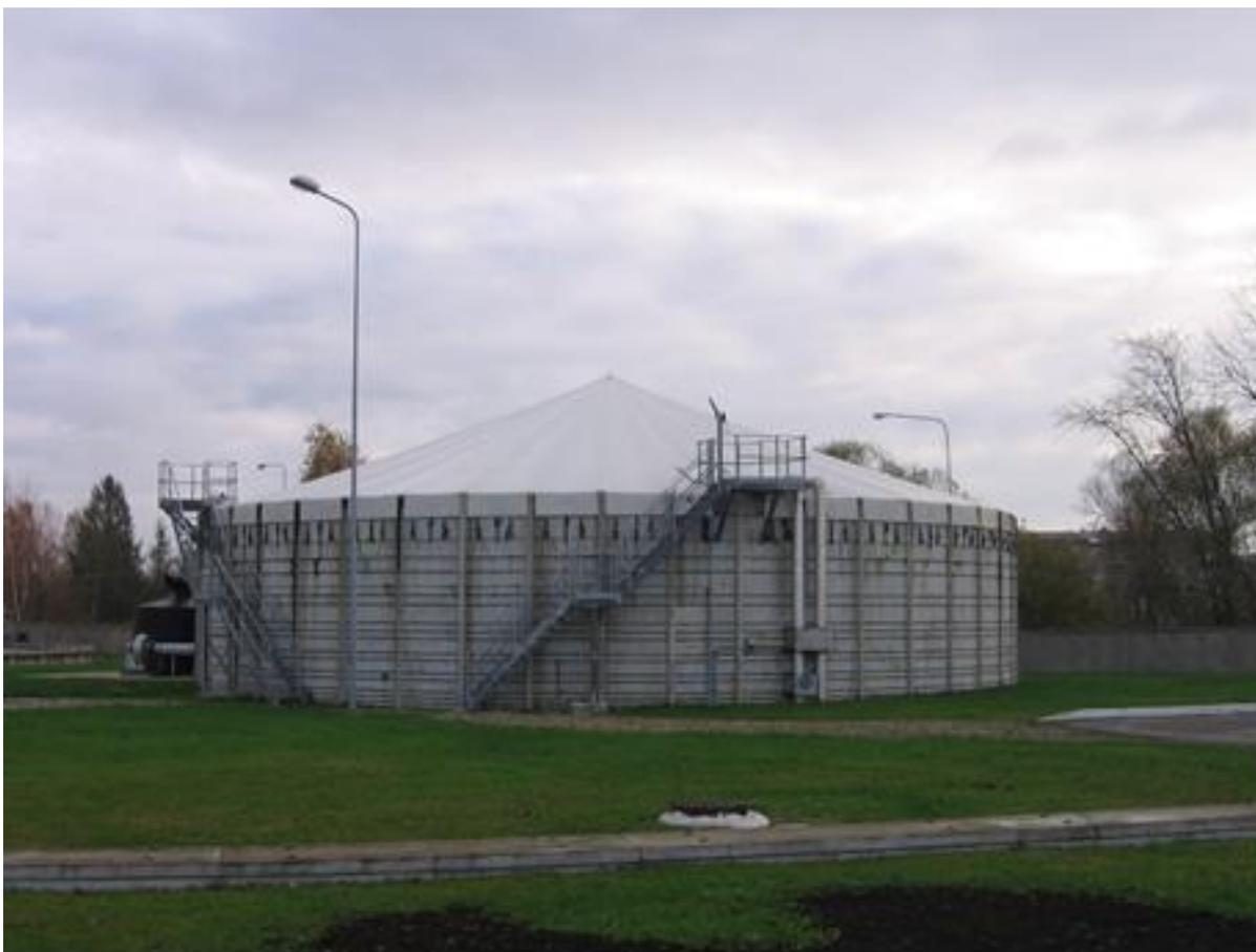
**Рисунок 1** – Перекрытие анаэробной ёмкости биологической очистки тканевым перекрытием (Очистные сооружения г. Даугавпилс)
