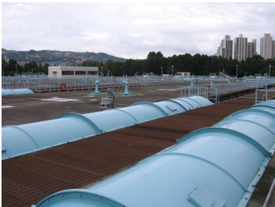
**Рисунок 2** – Перекрытие сооружений биологической очистки облегчёнными металлическими конструкциями (Очистные сооружения г. Сеул)
