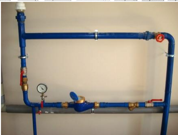
1. Задвижка; 2. Фильтр; 3. Проставка; 4. Счетчик воды; 5. Переход; 6. Тройник; 7. Крест специальный; 8. Колено; 9. Обводная проставка.
