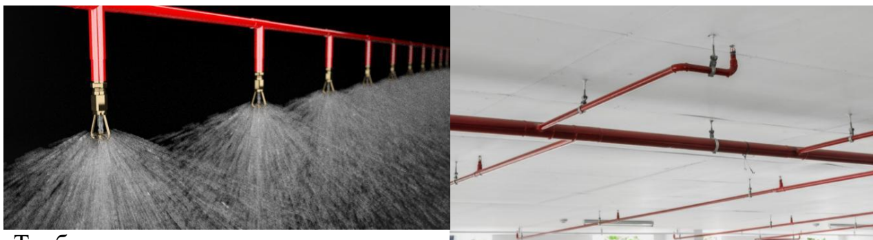
Трубопроводы со спринклерами
