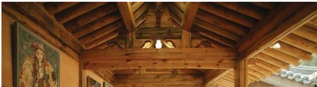
Рисунок 6 – Деревянные конструкции, поддерживающие свес крыши «чхома»
