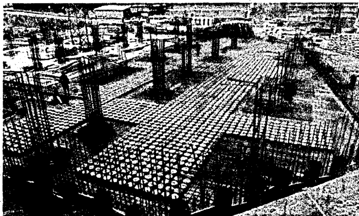
Рисунок 1 – Система перекрытий "BubbleDeck"
