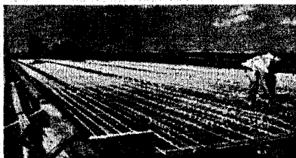
Рисунок 2 – Применение базальтовой арматуры при строительстве моста, Канада
