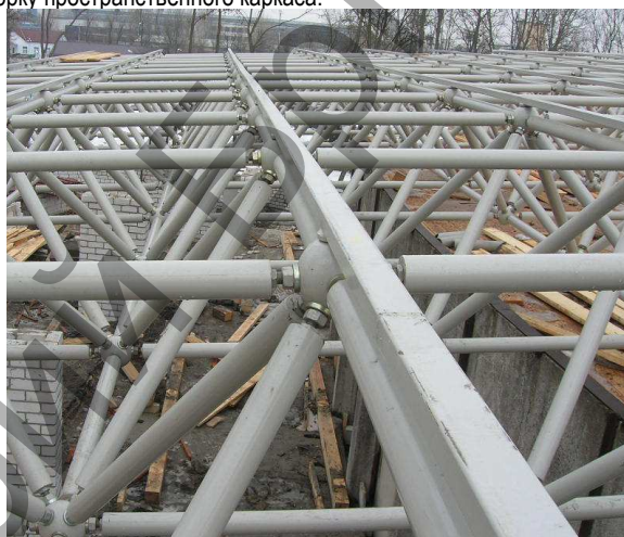
Рис. 1. Общий вид элементов структурной плиты покрытия сцены летнего театра в Бресте с узлами «БрГТУ» по патенту РБ №2489 и уложенными по подкладным шайбам прогонами
