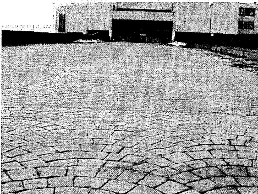
**Рисунок 7 – Устройство покрытия из напрягающего бетона пандуса Центра молодежного творчества в г. Бресте**
