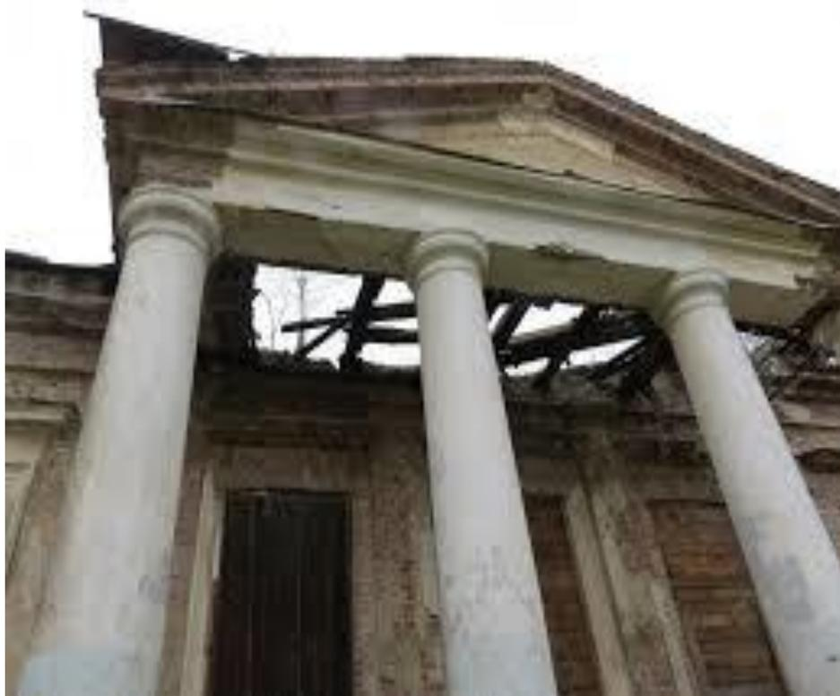
*Рисунок 6 – Аварийные элементы конструкций усадебного дома в д. Гремяча (фото 2011 г.)*
