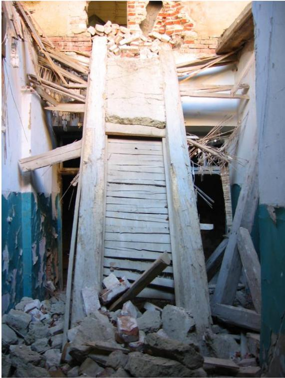
*Рисунок 4 – Частично обрушившиеся межэтажные перекрытия*
