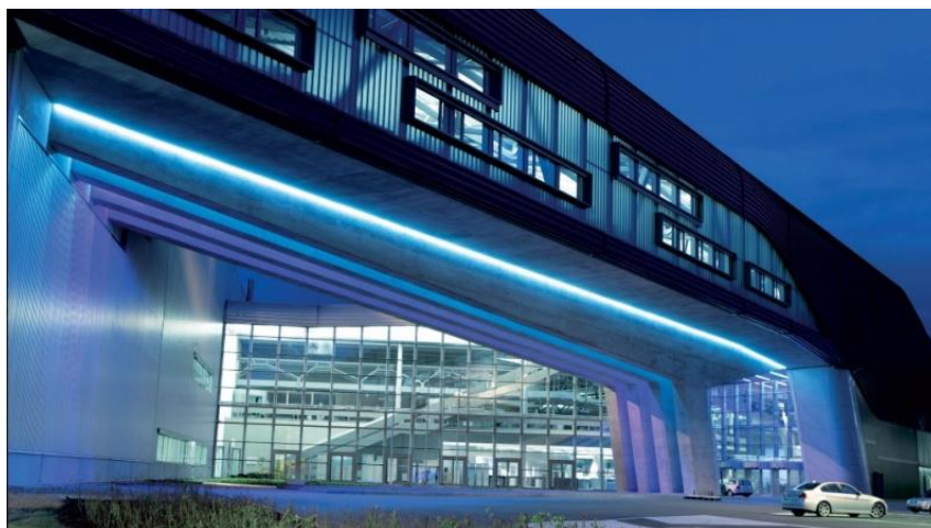
Рисунок 2 – Светопрозрачные панели из Литракона на офисном здании завода BMW в Лейпциге
