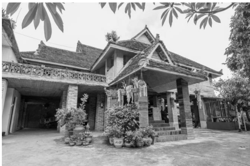
Рисунок 2 – Свайный дом Дай с несущей конструкцией из кирпичных колонн
