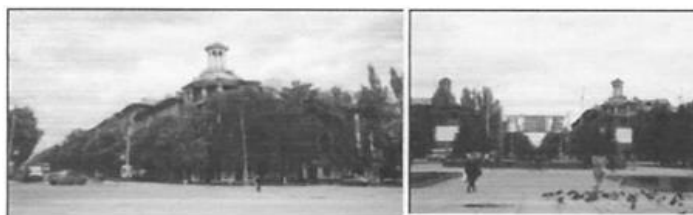
Рисунок 3 – Горловка. Центрально-Городской район. Главная ул. Центральная
