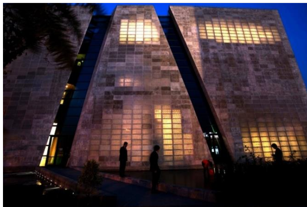
Рисунок 1 – Фасад павильона Италии на «ЭКСПО 2010» в Шанхае из светопроводящего бетона
