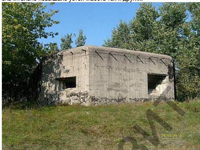
Фото 2. Дот 62-го Брестского укрепрайона, предназначенный для борьбы с танками
