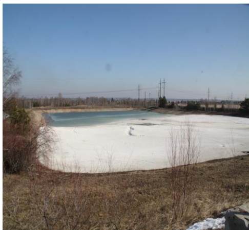
а) Очистные сооружения
