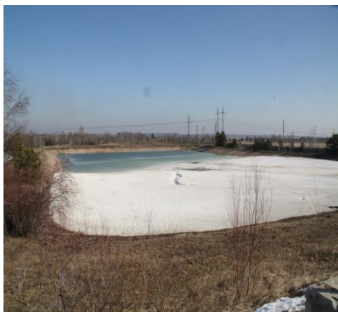
а) Очистные сооружения
