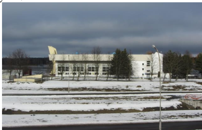
Рисунок 2 – Поверхностный водозабор на водохранилище Дрозды
