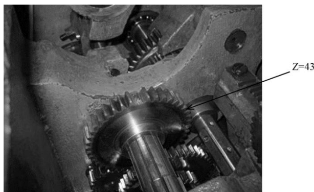
Рисунок 3 – Экспериментальная шестерня z = 43 , смонтированная по месту на 2-м валу привода
