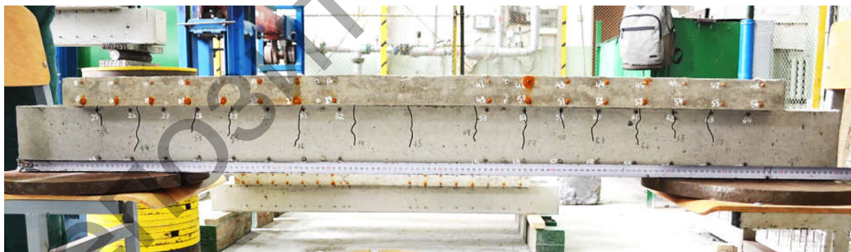
Рисунок 4 – Картина трещинообразования при выгибе балки
