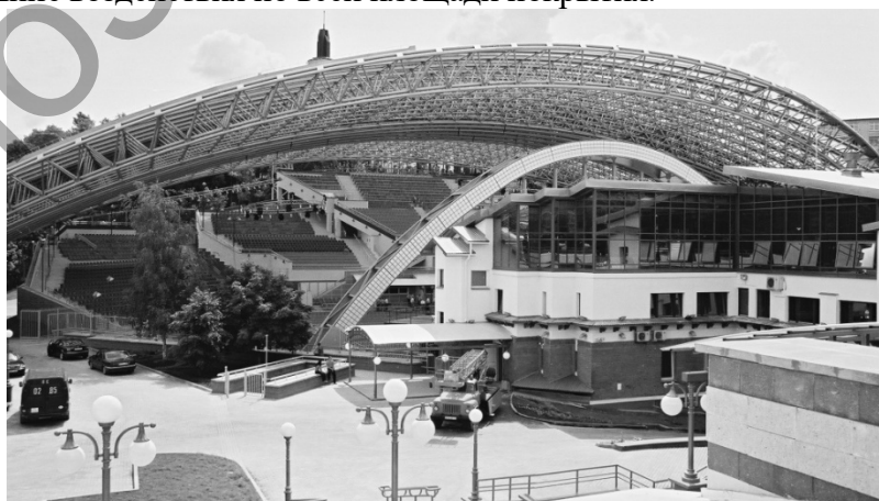
Рисунок 1 – Общий вид большепролетного структурного покрытия Летнего амфитеатра в г.Витебске
