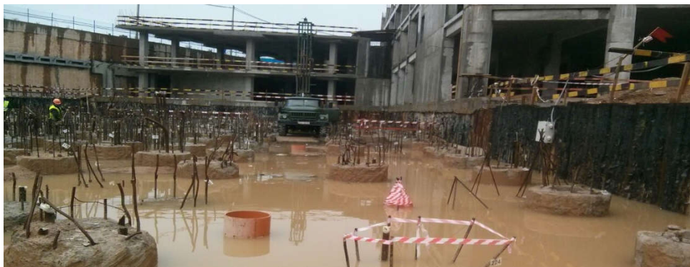
Рисунок 13 – Затопленный водой котлован с оголовками свай под высотное здание
