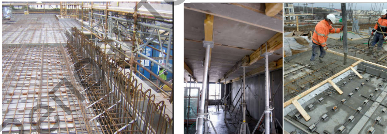
Рисунок 1 – Применение систем несъемной опалубки
