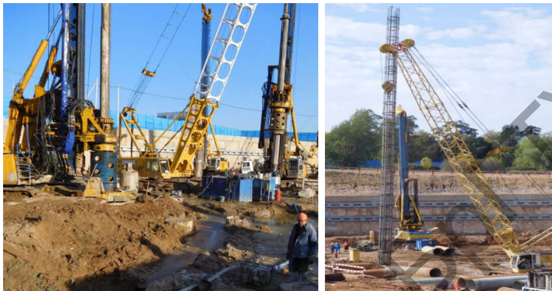
Рисунок 3 – Проходка скважин для буронабивных свай и монтаж армокаркаса
