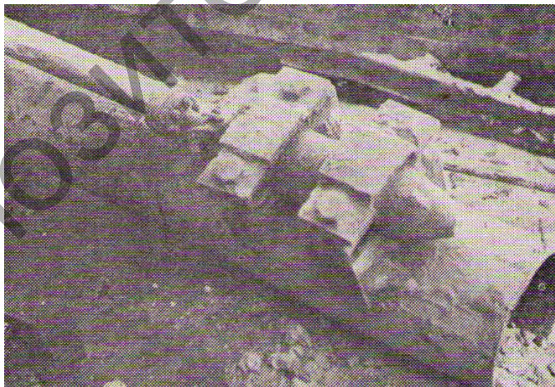
Рисунок 12 – Нижнее звено бетонолитной трубы с жестко прикрепленной вибробулавой для уплотнения выходящей из нее в глинистую суспензию полужесткой бетонной смеси
