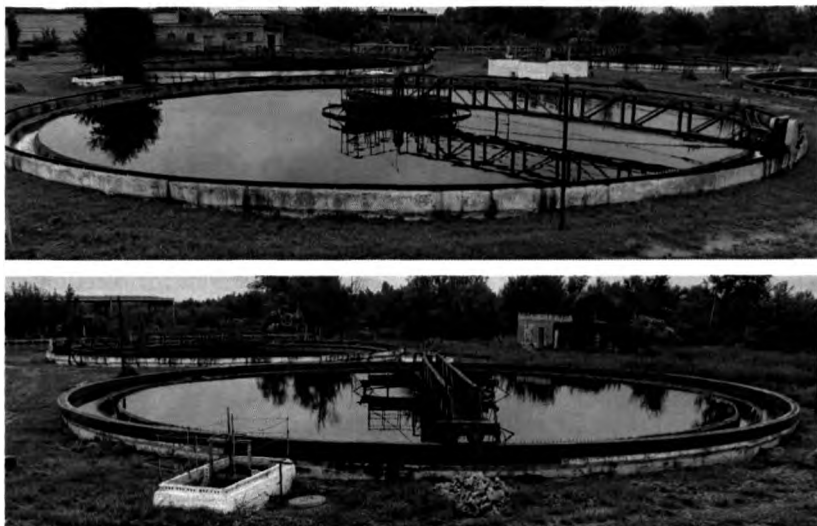
Рис. 4.11. Общий вид вторичных радиальных канализационных отстойников № 1–6 КПУП «Брестводоканал»
