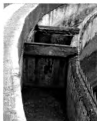
Рис. 4.12. Общий вид и конструктивное решение вторичных радиальных канализационных отстойников № 1 и № 2 станции КПУП «Брестводоканал»
