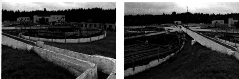
Рис. 4.7. Общий вид и конструктивное решение осветлителей-перегнивателей
