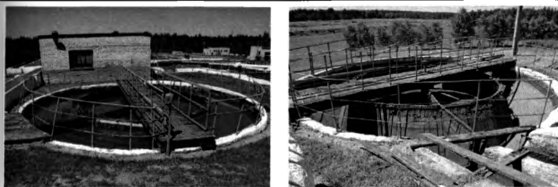
Рис. 4.3. Общий вид и конструктивное решение песколовков
