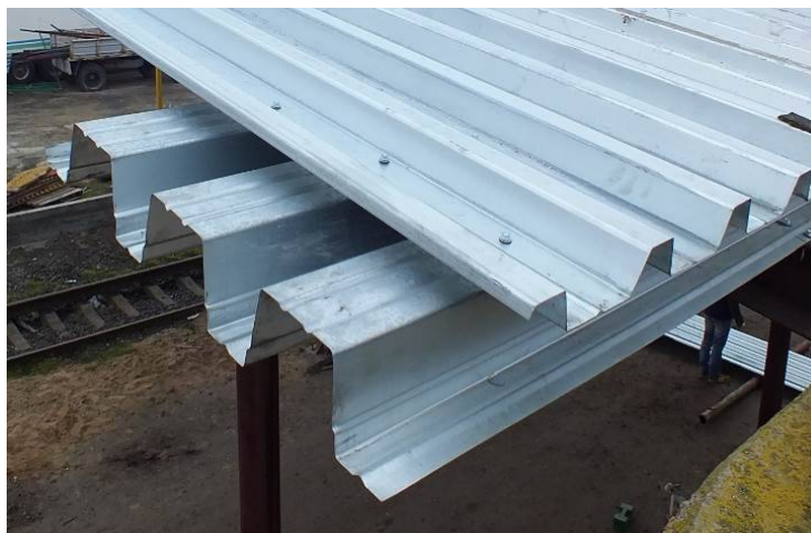
Рисунок 2 – Крепление карт настила: а) нижних; б) верхних
