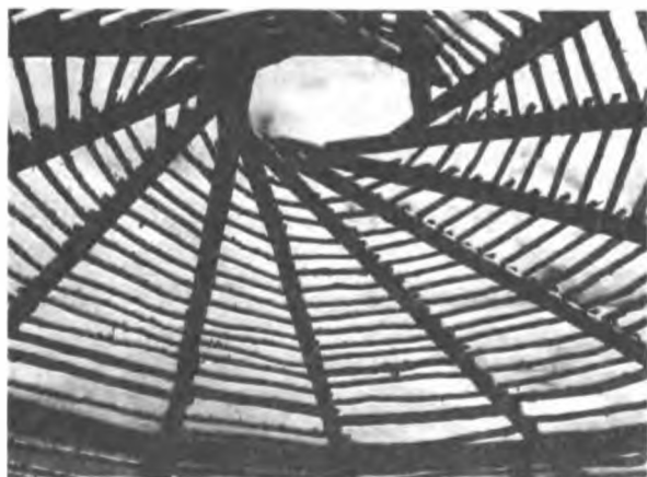
Рисунок 2 – Самоопирающаяся конструкция кровли
