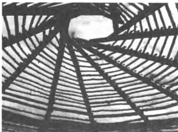
*Рисунок 2 – Самоопирающаяся конструкция кровли*
