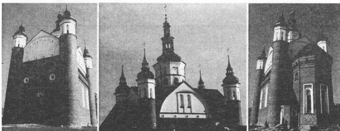
Rysunek 28–30 – Widoki cerkwi monastycznej Zwiastowania Przenajświętszej Bogurodzicy w Supraślu od strony zachodniej, północnej i wschodniej. Stan istniejący (fot. J.Uściniowicz)
