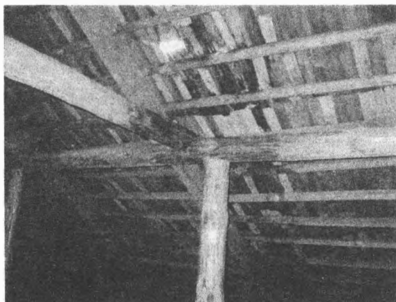
Рисунок 24 - Поражение гнилью гонта (фото слева). Разрушение кровли (фото справа)
