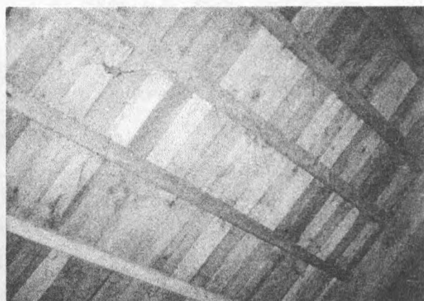
Рисунок 23 - Конструкция кровли (фото слева). Обрешетка и настил из гонта (фото справа)
