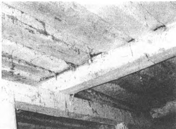
Рисунок 19 - Балки чердачного перекрытия (фото слева). Опираение балки перекрытия на прогон, стык балки (фото справа)
