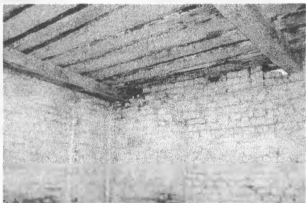
Рисунок 20 - Опираение балок на наружные продольные стены (фото слева). Настил чердачного перекрытия (фото справа)
