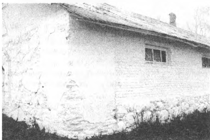
Рисунок 13 - Вид кладки стен с наружной стороны. Западный торцевой и южный продольный фасады
