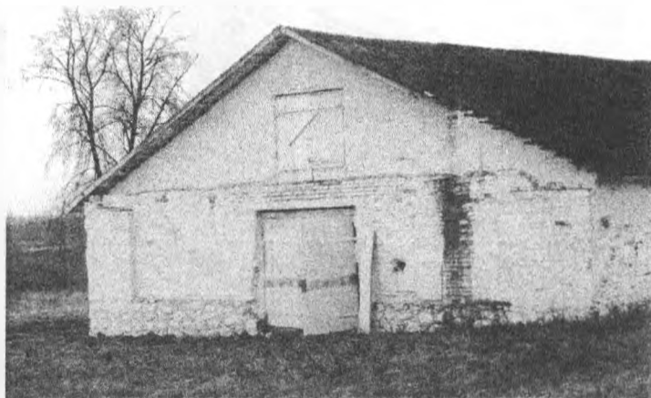
Рисунок 5 - Вид здания конюшни. Восточный фасад
