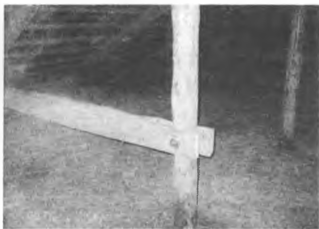
Рисунок 28 - Ригеля жёсткости (фото слева). Опирание стропильных ног на мауэрлат (фото справа)
