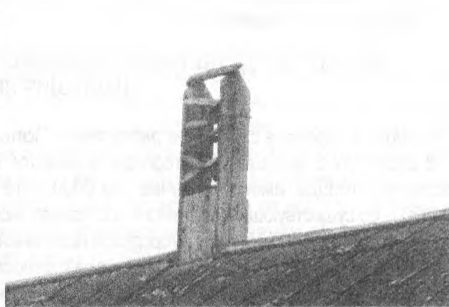
Рисунок 29 - Вентиляционный канал в помещении конюшни (фото слева). Состояние оголовка вентиляционной шахты над кровлей (фото справа)
