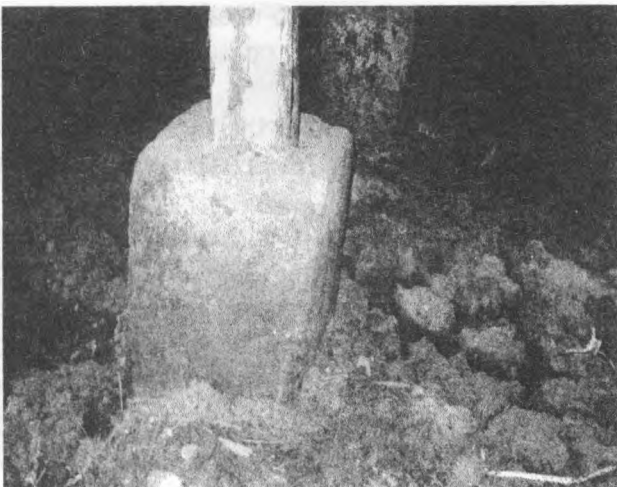
Рисунки 10,11 - Столбчатые фундаменты под деревянные стойки. Шурф ШФ-5
