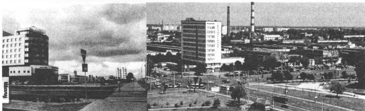
Рисунок 4 – Панорама застройки по ул. Московская, г. Брест
