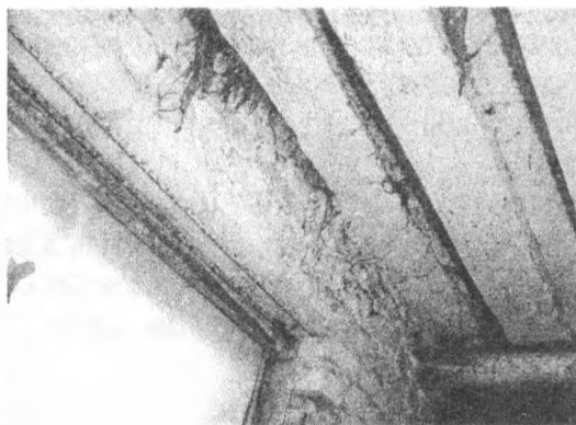
Рисунок 15 - Перекрытие оконного проёма металлическими стержнями
