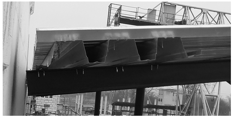
Рисунок 2 – Крепление карт настила
