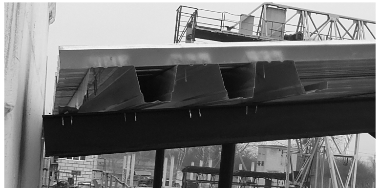
Рисунок 2 – Крепление карт настила
