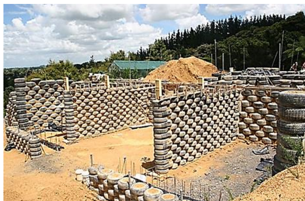
Рисунок 1 – Возведение стен и перегородок из шин
