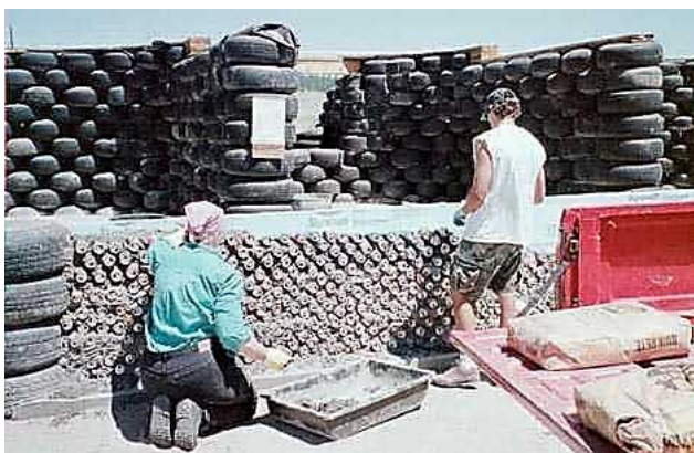
Рисунок 1 – Возведение стен и перегородок из шин
