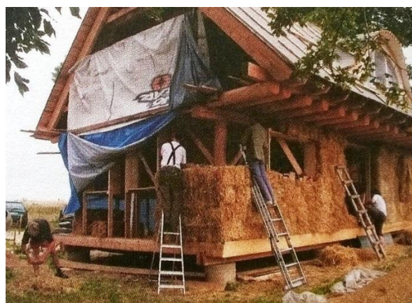
Рисунок 1 – Технология возведения каркасного дома из соломенных блоков
