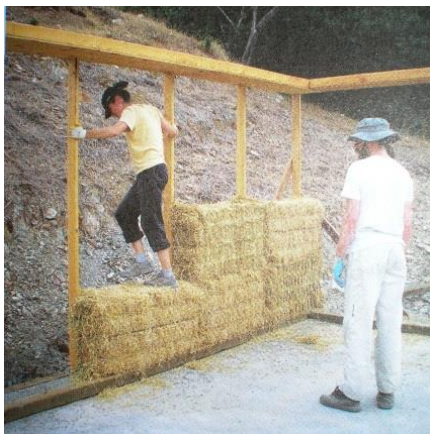
Рисунок 1 – Технология возведения каркасного дома из соломенных блоков
