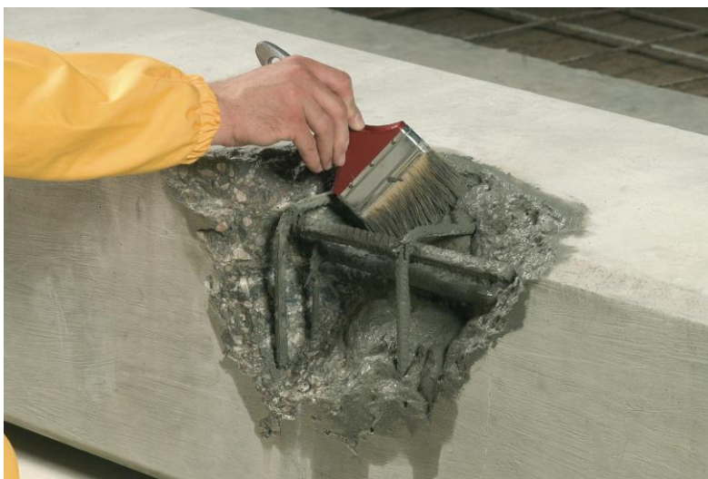
Рисунок 5 – Комплексная защита бетона от коррозии
